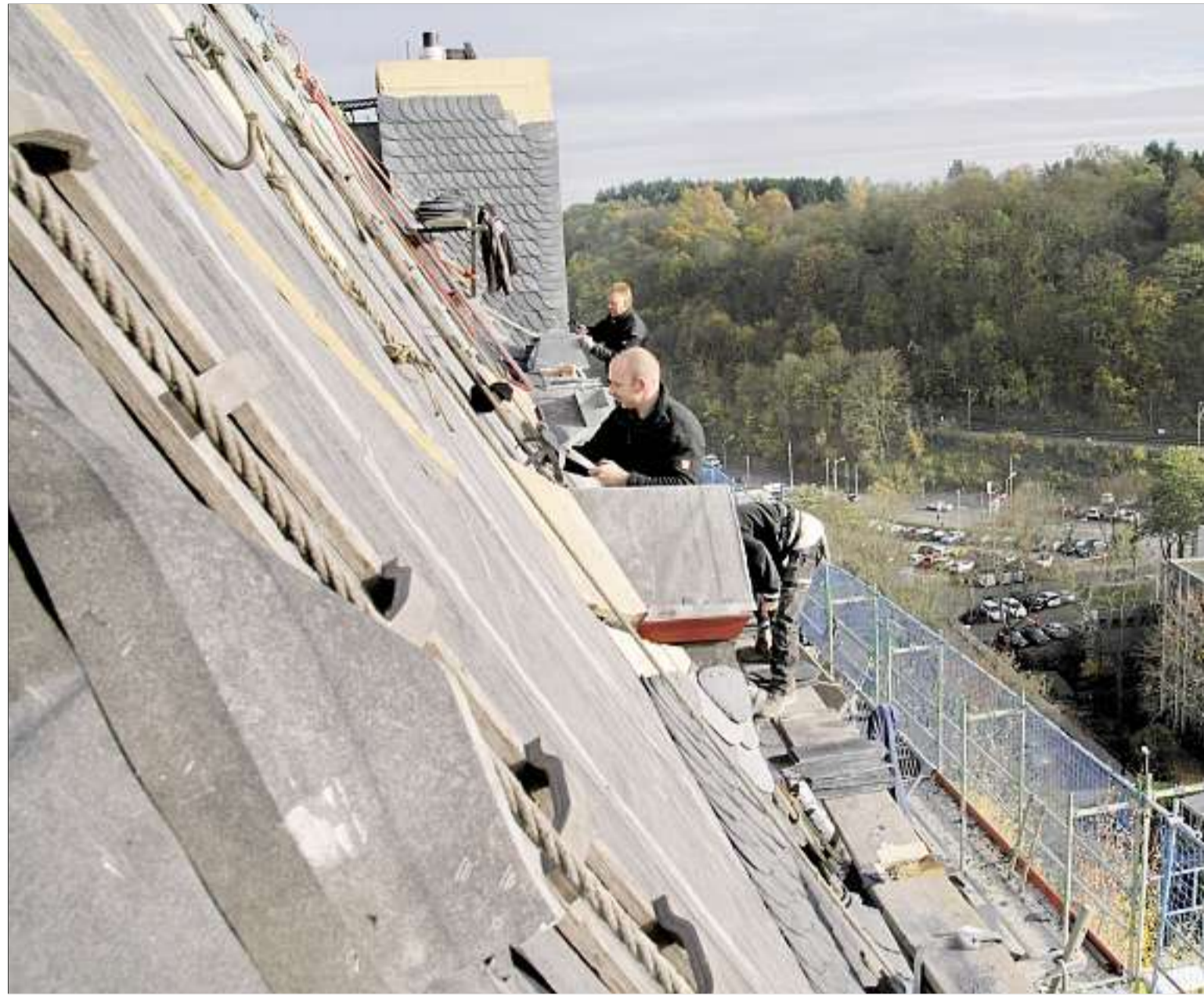
Chef Uwe Durben ist mit der Verschieferung des Kamins beschäftigt, seine Mitarbeiter Michael Kops und Lukas Keldenich nageln die Schieferplatten auf die große Dachfläche. Foto: Laubach
